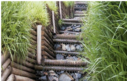
Figura 36 - Escada hidráulica em material natural
