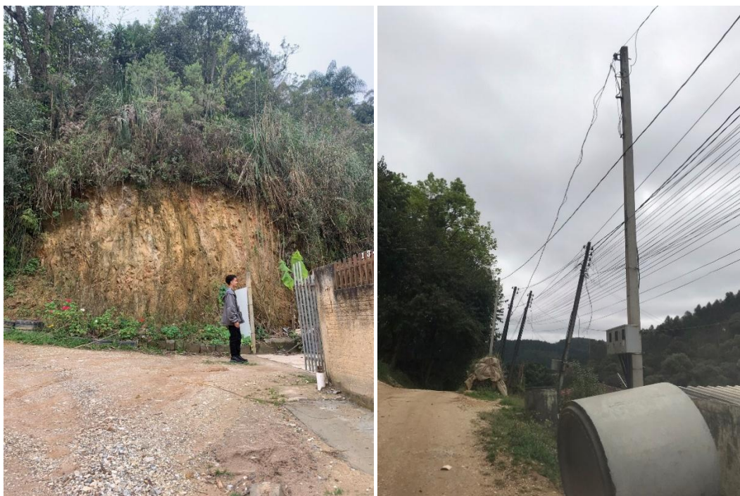
Figura 102 - Talude da casa com problemas de concentração da água da chuva devido à falta de drenagem da rua a montante (à esquerda) travessa Particular II com postes inclinados (à direita)
