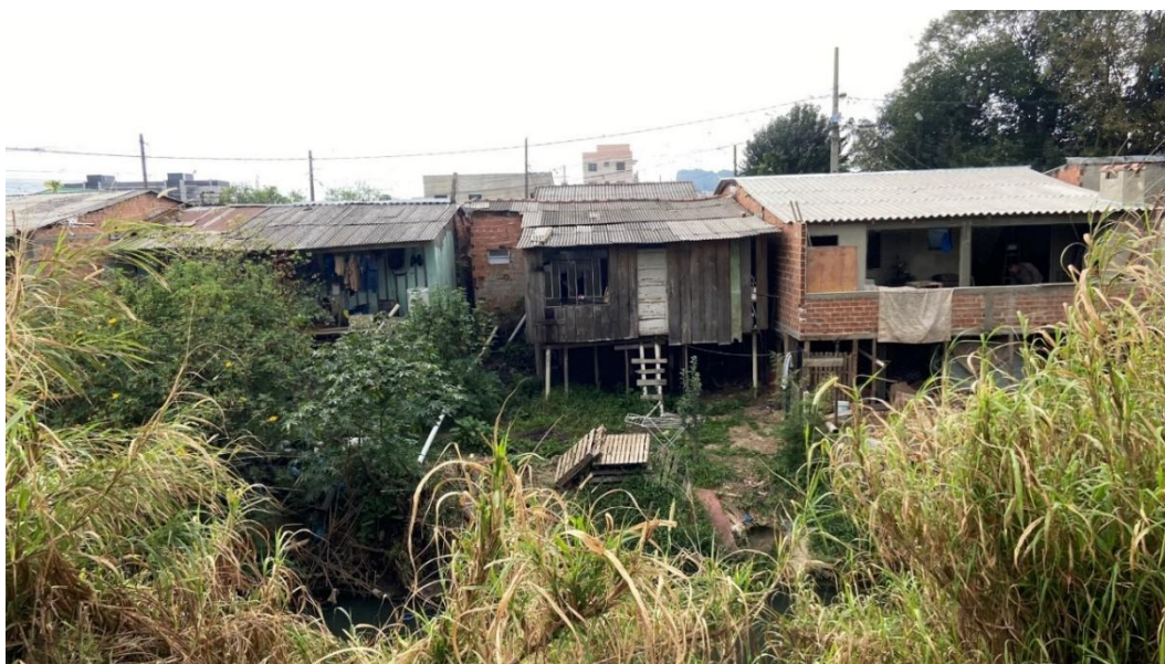
Figura 24 - Moradias próximas à margem do curso d'água com pilares de madeira e sinais de fragilidade construtiva
