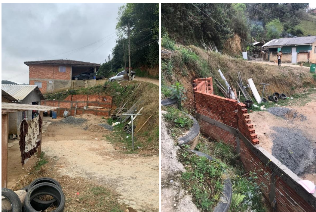
Figura 103 - Obra para contenção do acesso às casas da meia encosta
