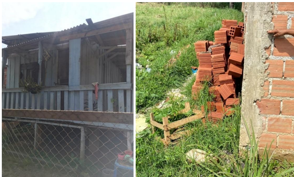
Figura 71 - Edificação elevada para reduzir o impacto das enchentes (à esquerda) e indicação da altura da lâmina d'água, lixo e entulho acumulados (à direita)
