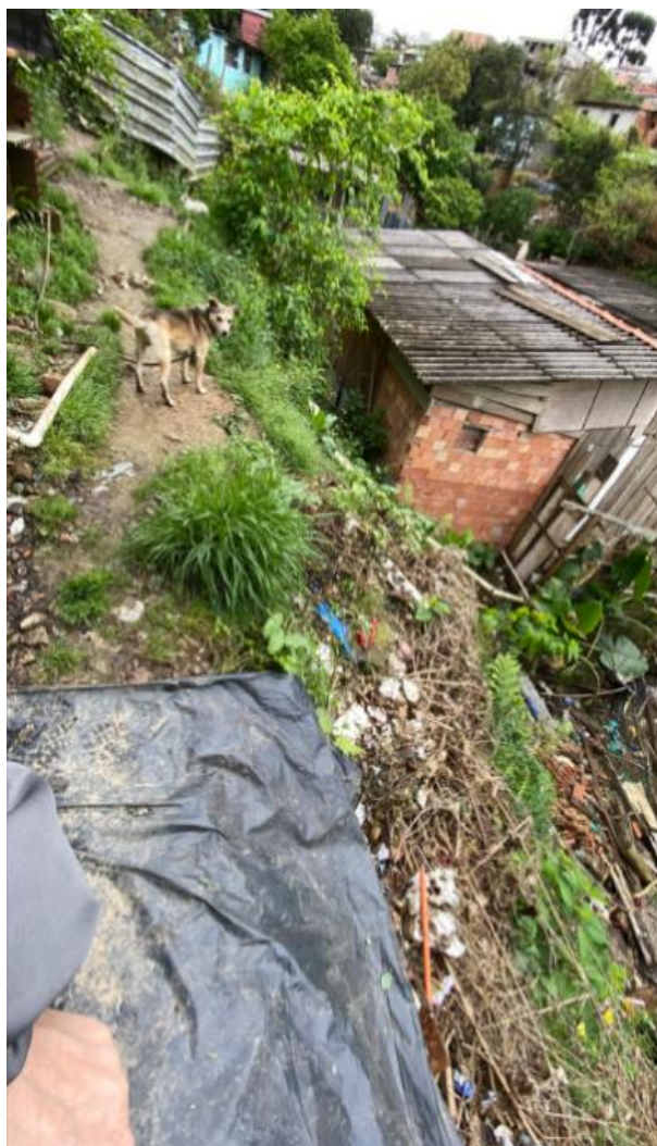
Figura 63 - Talude a jusante da edificação do setor 3 com lona plástica devido a deslizamentos anteriores
