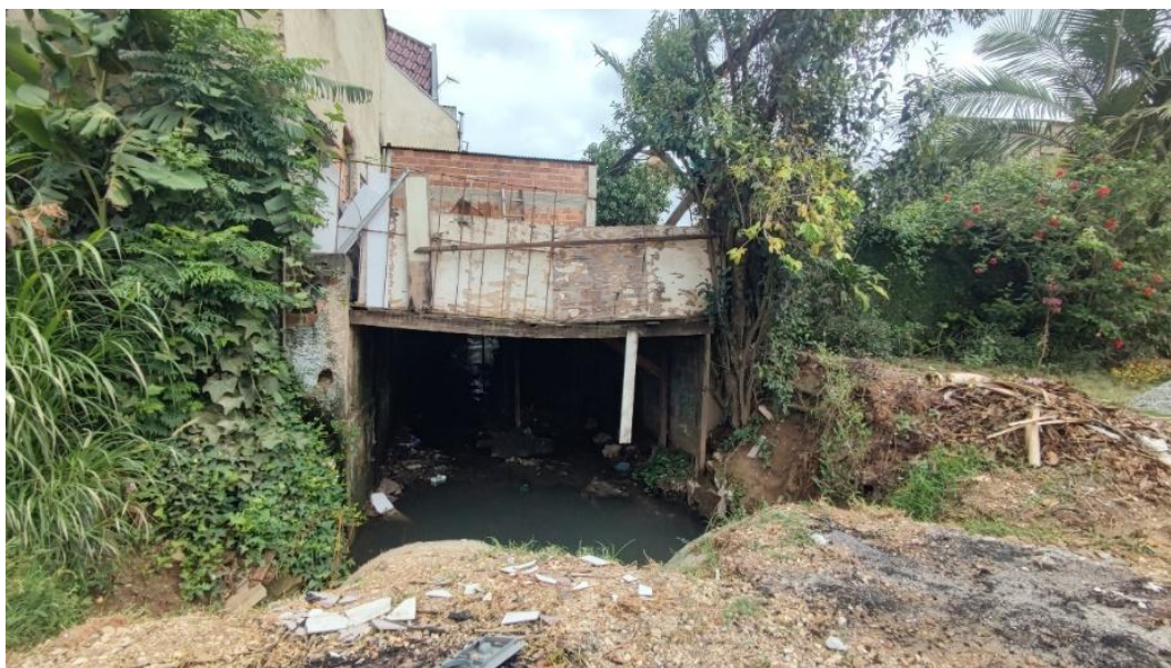
Figura 51 - Quintal de uma moradia em cima do córrego formando galeria improvisada
