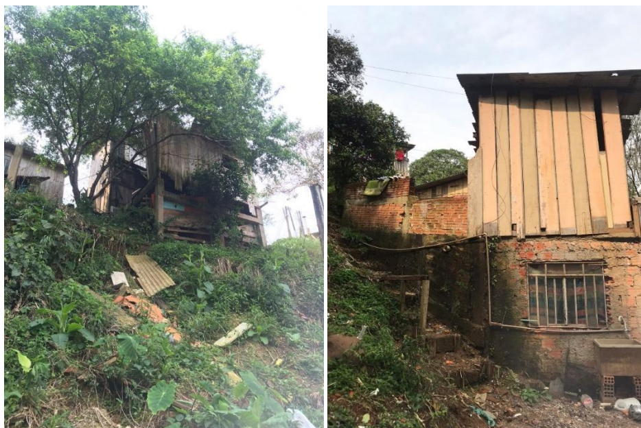
Figura 85 - Depósito de entulho e lançamento de aterro sobre a encosta do Setor 1 (à esquerda) e edificação a menos de 1 metro da parte mais acentuada da encosta (à direita)
