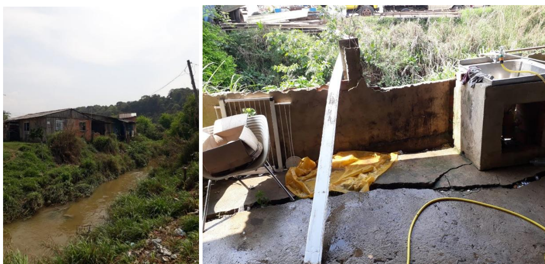
Figura 73 - Proximidade das edificações do Setor 2 ao rio Atuba (à esquerda) e trincas na lavanderia de edificação na margem do rio Atuba
