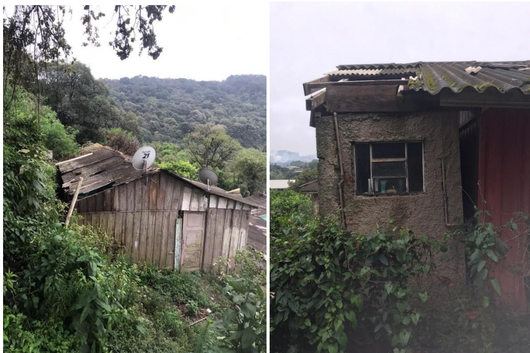
Figura 91 - Casa desocupada com piso e telhado danificados, recomenda-se interdição (à esquerda) e banheiro apoiado em aterro e deslocado do resto da edificação (à direita)
