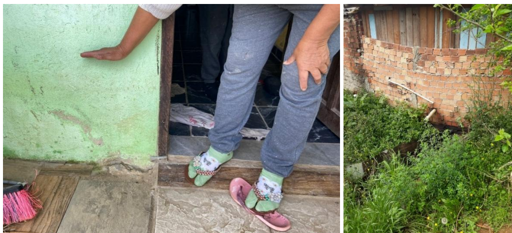
Figura 75 - Indicação da altura da lâmina d'água durante o processo de inundação no setor 3 (à esquerda) e trecho de galeria obstruída por edificação do Setor 3
