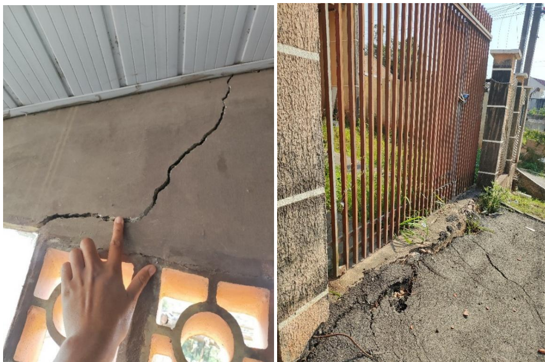
Figura 31 - Trinca dentro de residência do setor COL06_S1R2 e afundamento da calçada na rua Presidente Faria
