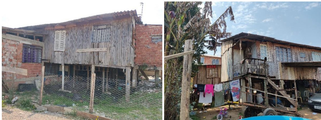
Figura 15 - Edificações suspensas por pilares de madeira, próximas à margem do rio Palmital, sujeitas a enxurrada e impacto de materiais pesados que o curso d'água transporta em dias de chuva intensa
