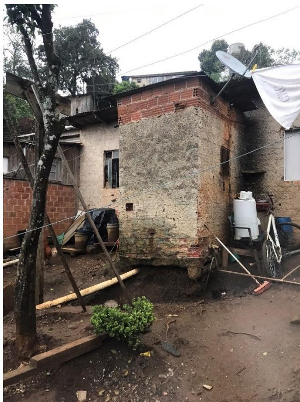
Figura 92 - Cômodo descalçado devido a concentração do escoamento superficial das águas de montante
