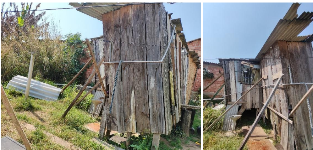
Figura 17 - Moradia do Setor 03 (R4) com indicadores de fragilidade construtiva e tentativa insuficiente de estabilizar a estrutura
