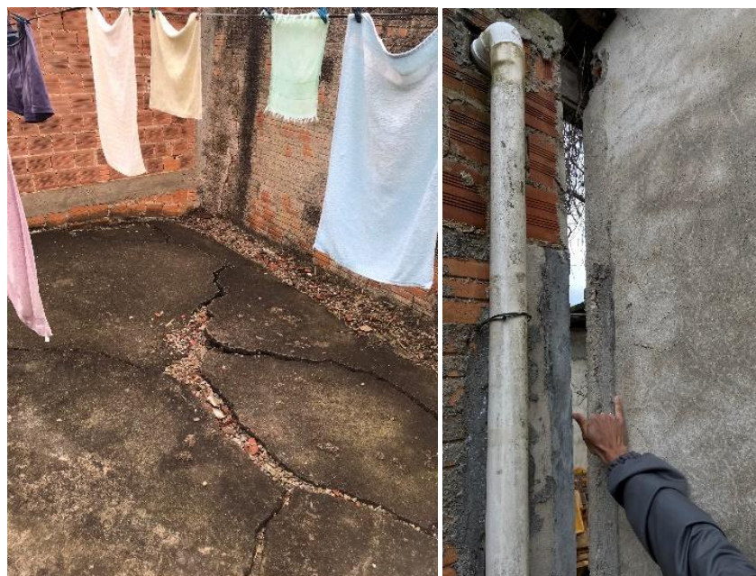
Figura 39 - Evidências de movimentação no quintal das edificações do Setor 2
