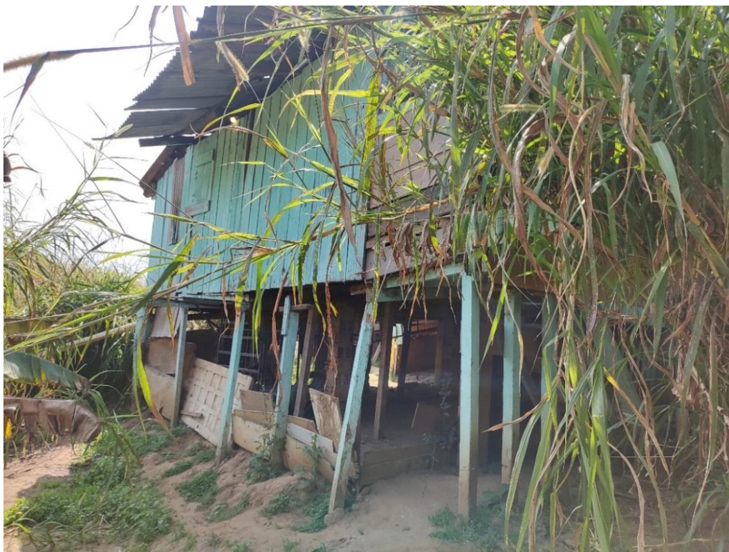
Figura 14 - Moradia próxima à margem do rio Palmital com pilares de madeira e sinais de fragilidade construtiva
