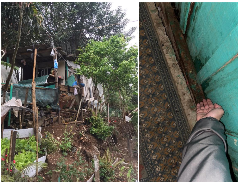
Figura 42 - Quintal nos fundos da moradia do setor 03 (R3) na margem do rio Atuba e vão entre parede e o piso da edificação na parte interna
