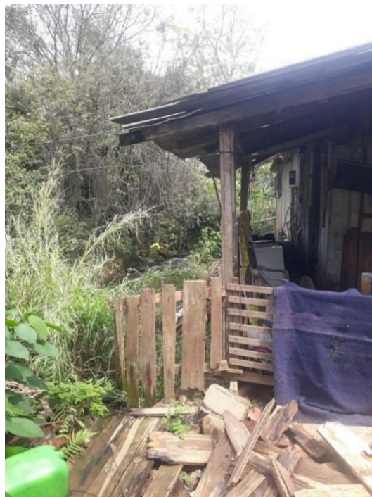
Figura 79 - Edificação da madeira com evidências de solapamento na área de serviço
