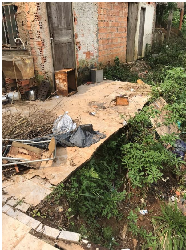
Figura 86 - Contrapiso de casa atingida por deslizamento pretérito
