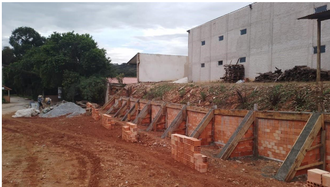
FIGURA 25 – Muro de contenção em local de afundamento cárstico no Bairro Bacaetava
