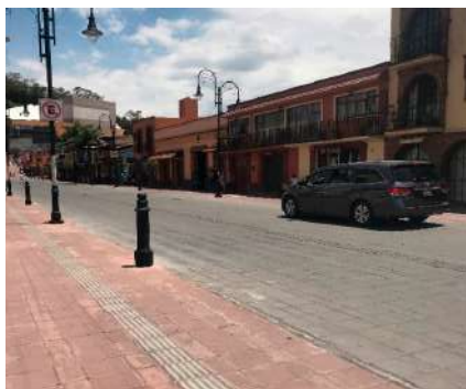
Imagen 17. Guías podotáctiles en zonas peatonales
