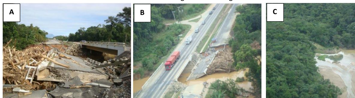
FIGURA 16 – Impactos dos deslizamentos e corridas de massa de março de 2011 na infraestrutura viária e de abastecimento de água em Paranaguá.
