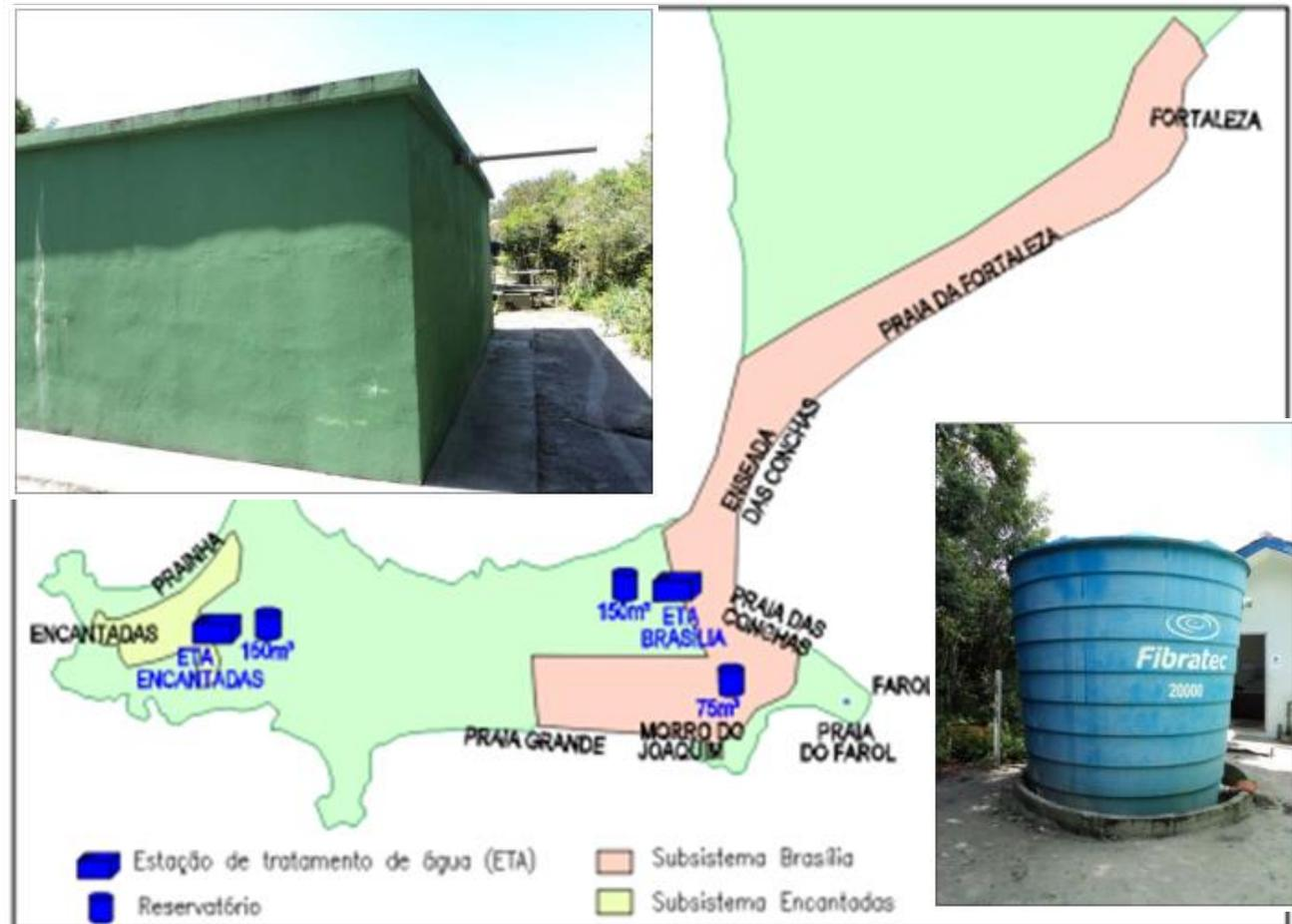
Figura Reservatórios apoiados de água tratada do Subsistema Brasília (Fonte: Paranaguá, 2011).
